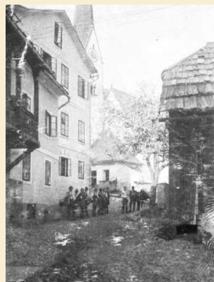
Links: das Kramerhaus und dahinter die Volksschule (vormals Messnerhaus)
